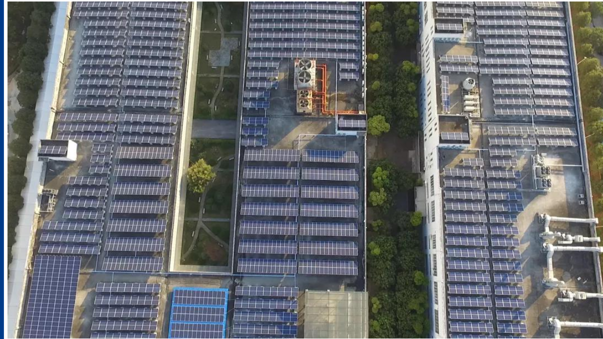
Rooftop Distributed Photovoltaic Power Project 屋顶分布式光伏发电项目
